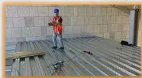
Material sumamente resistente, su fortaleza le permite ser usado como plataforma y materia principal en una construcción. Se compone de una lámina galvanizada y acanalada que se usa principalmente en la construcción de entresijos metálicos y en la cimbra
